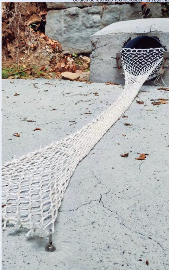
Colares de retenção TecnoGrabber® em aço inox
